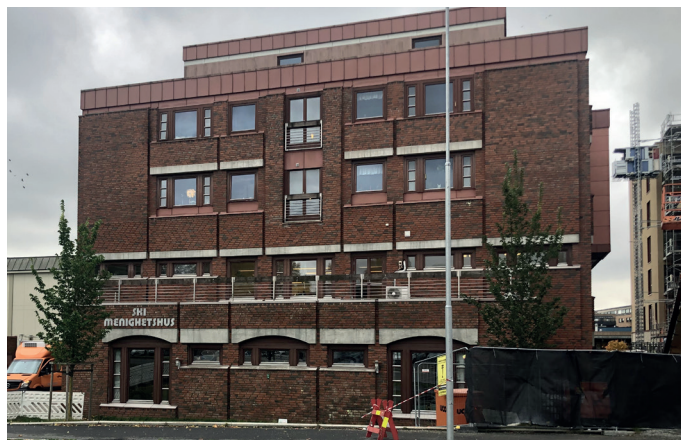
Menighetshuset har i dag lokaler i første etasje i bygget fra 1983.
