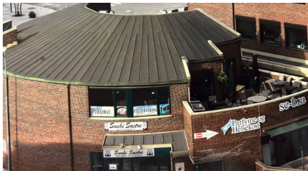
Dette er Se-Bra-bygget anno 2025. Bygget eies av søsknene Britt Huseby Hedstrøm og Roy Huseby.
