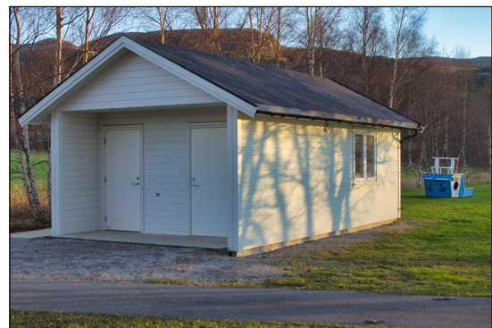
Det nye sanitæranlegget ble tatt i bruk i 2018. Foto: LV
