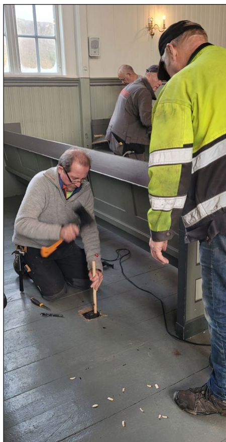
Asbjørn plugger igjen hull fra de gamle ovnene.
