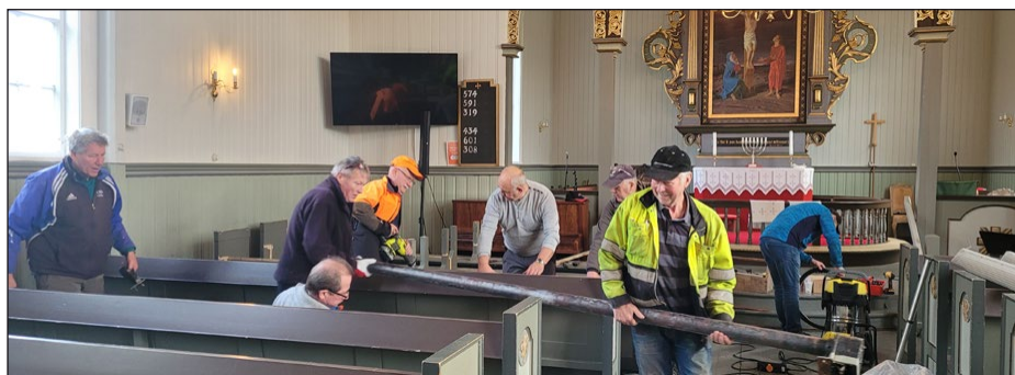
Gamle rørover bæres ut.
