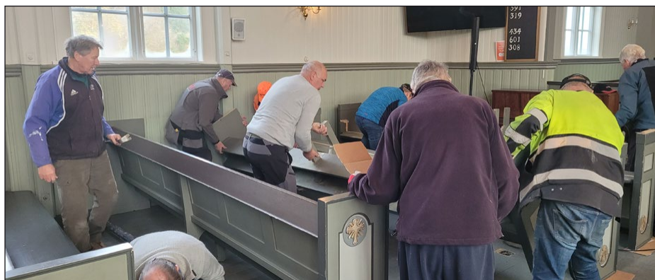
Benker blir snudd for å lette arbeidet.
