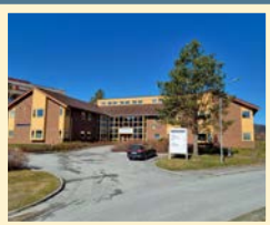
Ombygging av kommunehuset side 8
