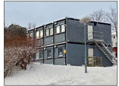
Arbeidsbrakke satt opp ved kommunehuset. Foto: Astrid Nora Tøndel
