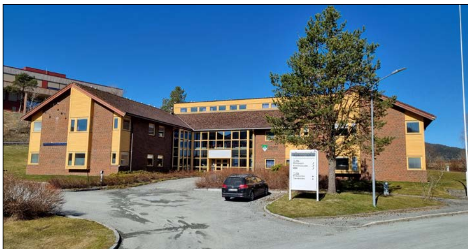
Fasaden på huset blir som før.
