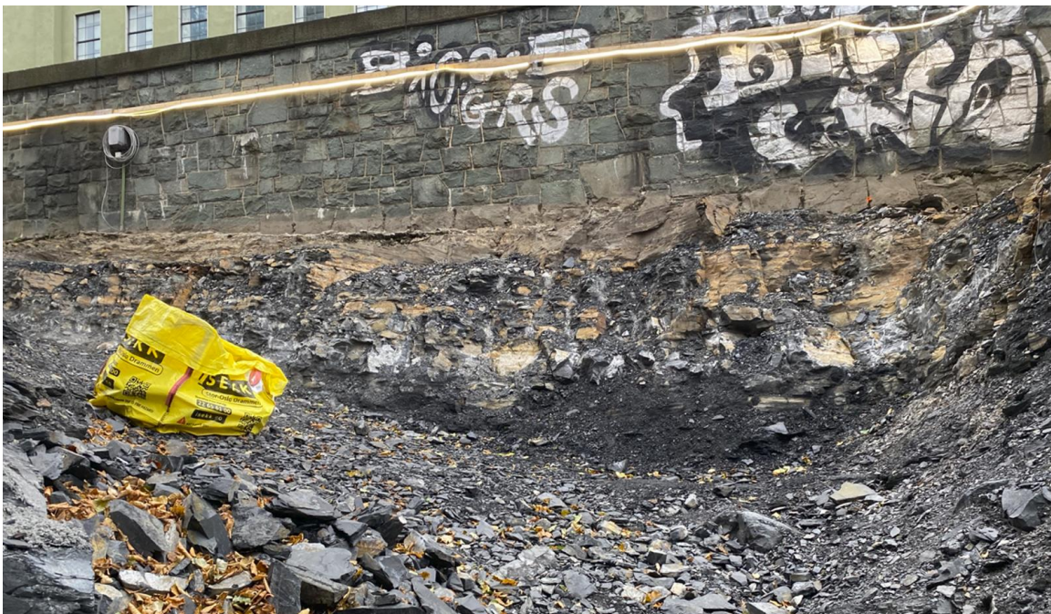
Figur 5. Rustbrune flater viser sprekkesett/sprekkeflater i dette området. Det er minst tre sprekkesett med ulik orientering.
