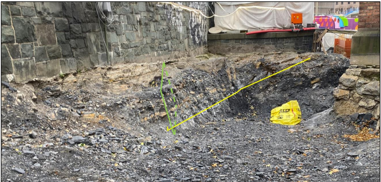
Figur 3. Deichman muren til venstre. Gul linje viser retningen på lagdelingen/skifriheten. Grønt rektangel viser orientering på ett av flere sprekkesett i leirskiferen i dette området. Over den gule linjen er det en mer kalkrik leirskifer. Under den gule linjen er det svart leirskifer. Til venstre for den gule sekken i bildet er den svarte leirskiferen forvitret til små fragmenter. Det er også vått i dette området. Fukt siger ut gjennom volumet til den svarte leirskiferen under den gule linjen. Kulverten som skal etableres vil gå ned i den svarte leirskiferen.
