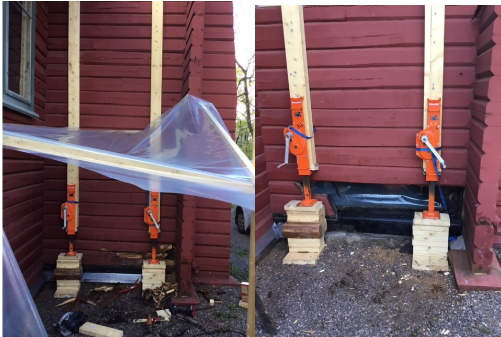
1 Råtestokker nederst på tårnet fjernet og felt inn nytt virke.
