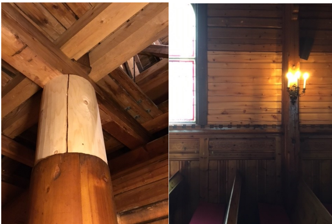
3 Bilde til høyre, friskt virke fra forrige vedlikeholdsrunnen i 2017-2018 er nå behandlet.
