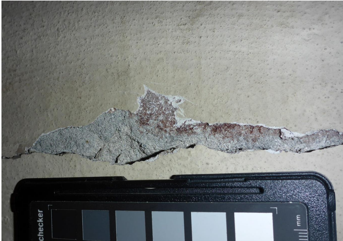
Bilde 10: Under vinduet nærmest koret, har det tidligere vært en nisje, trolig for en radiator. Innmuringen er noe løs, og i overgangen mot den faste ytterveggen er det skader – som er fine å sjekke ved en slik undersøkelse. Her fant jeg da også de første spolene etter den rødlige brystningen – se øvre del av avdekningen.
