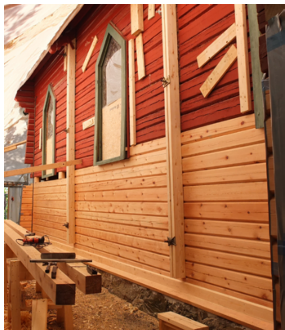
Slik så den ene, utvendige siden av kirken ut under arbeidet.
