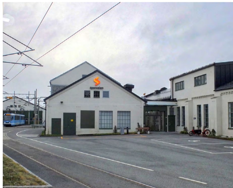
Holtet trikkebase: Bygningene – som er tegnet av arkitekt Erik Waldemar Glosimodt – er listeført som verneverdige kulturminner og står på byantikvarens gule liste.
