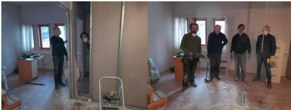
Rivning av vegger i møterom/ekspedisjon/lager ble gjort på dugnad..
