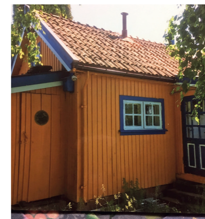
Typisk hyttebygg i Kapein Oppegaards vei 20, reist omkring 1925. Gunnar og Madeleine Åbyholm bodde på Kampen, han var rørlegger på Akers Mek. De flyttet hit om sommeren med fem barn og bodde her i helgene. På trettitallet bygde de et nytt hus nærmere veien. Det ble senere revet og erstattet med det nåværende. Foto: RØB
