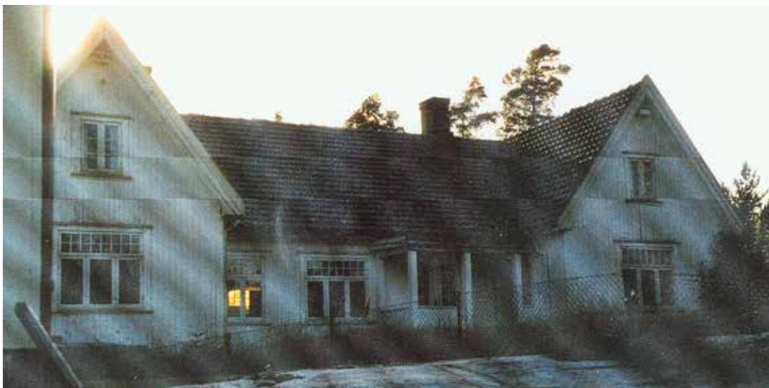
Jørgensløkken til sist med navnet Solbakken. Hovedhuset var ganske stort, revet ca. 1990. Bildet er tatt kort før rivning. Plassen lå på nordsiden av Østmarkveien vis a vis eldreboligene. Kilde: Østensjø lokalhistoriske bilder, bilde-nr. B20040237. For flere bilder, se: http://bildebaser.deichman.no/ .
