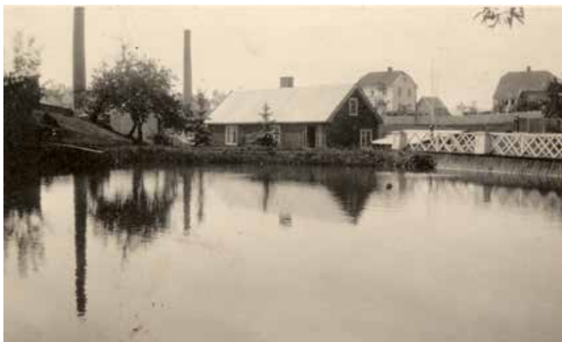
Mølledammen, foto ca. 1930, har navn etter den første bruken, nemlig som kraftkilde til brisselmøllen til P.W.W. Kildal i 1850-årene. Dammen hadde også en tid navn etter eieren av Høyenhall Fabrikker, da kalt "Fettdammen". Skorsteinene tilhører Høyenhall Teglverk og Høyenhall Fabrikker. Kilde: Østensjø lokalhistoriske bilder, bilde-nr. B20100090. For flere bilder, se: http://bildebaser.deichman.no/ .
