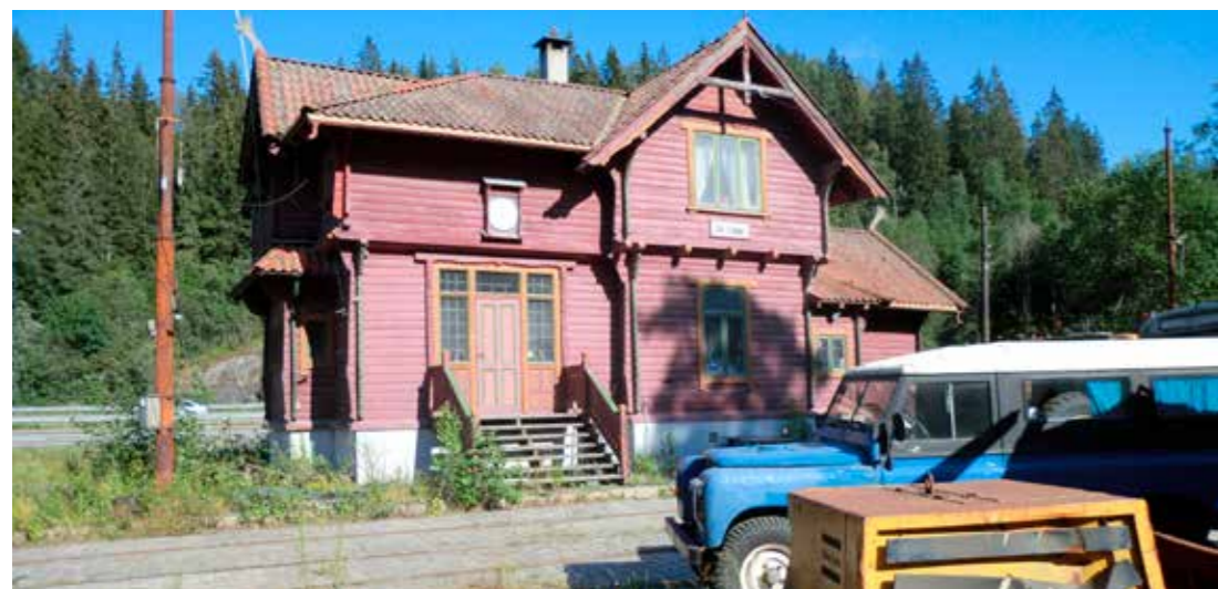
Slemdal stasjon står i dag ved "Tusenfryd" på Vinterbro lett synlig fra motorveien med "ryggen mot" E6.
