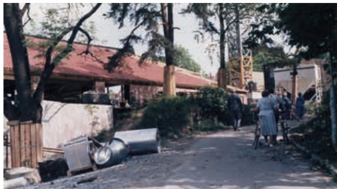
Byggeplassen for nesten 30 år siden.
