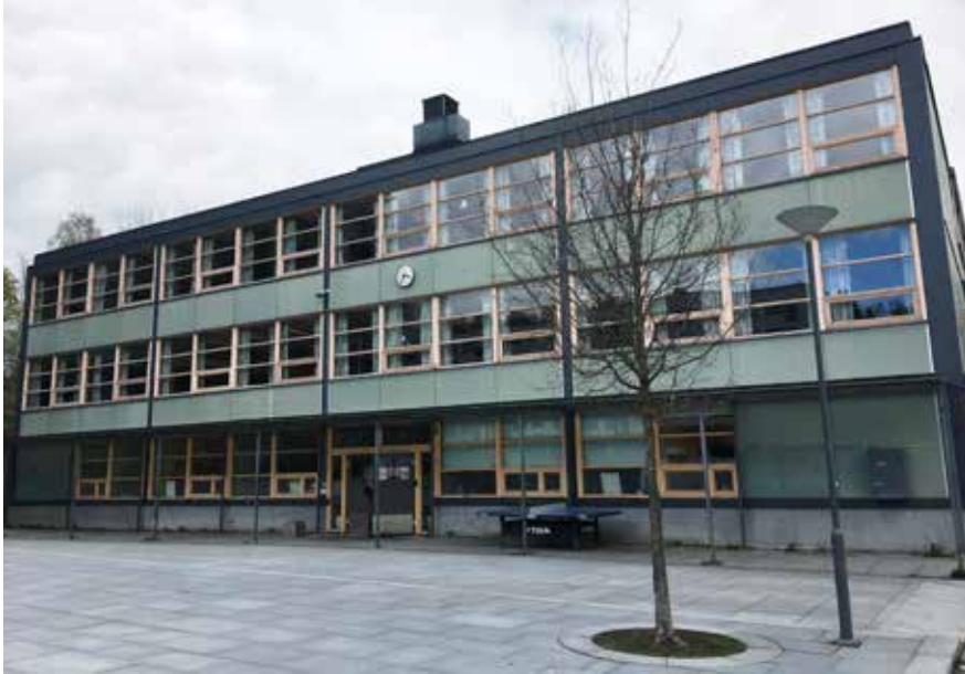
Hovseter skole venter på byggearbeidet.
