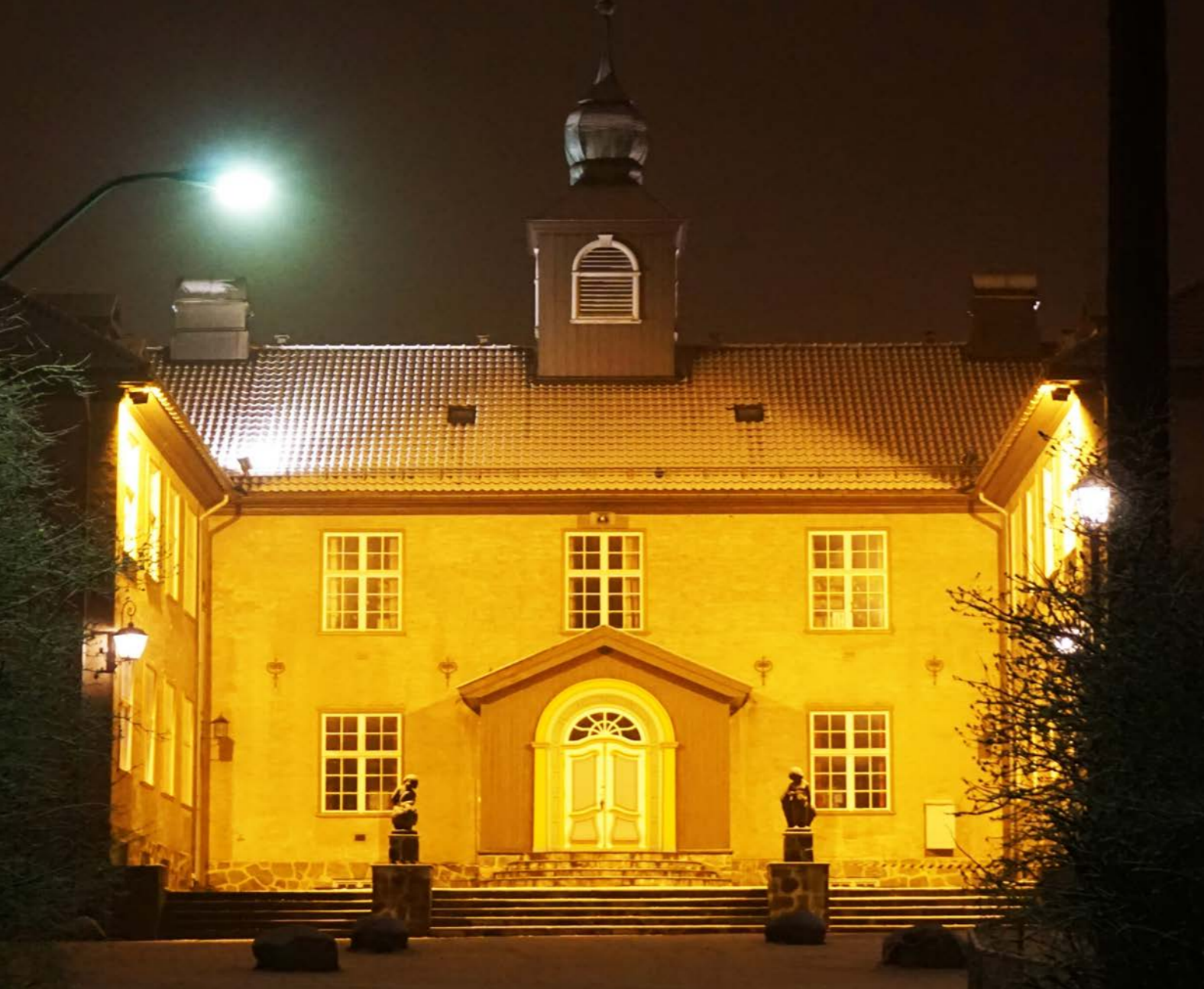
Ljan skole (1923) er bygget etter mønster av herregården på Stubljan, og er nærmeste nabo til kirken. Da blir det kort vei for et godt samarbeid.
