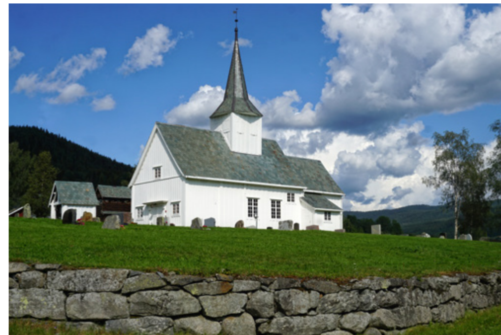
En spesiell detalj ved Volbu kirkegård er steinmuren som omkranser den.
