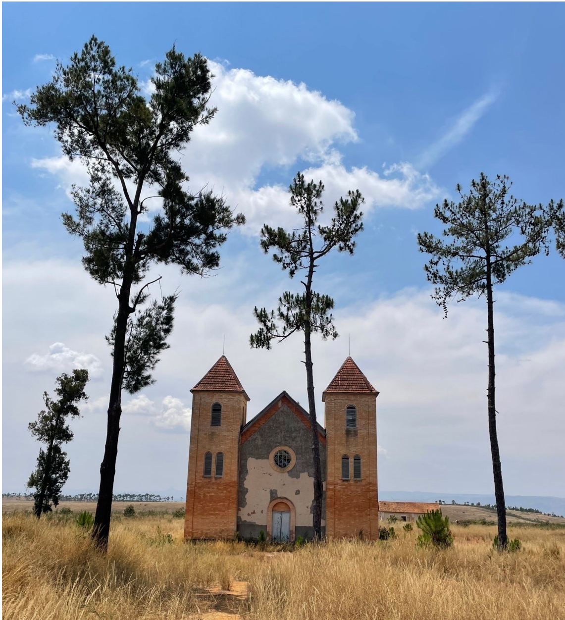
Den flotte kirken har ikke vært i bruk på mange år. Den er for stor til en såpass liten forsamling. Dessuten er taket lekk flere steder.
