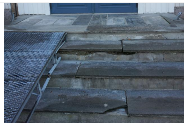
282: Trapp i skifer med manglende stein.
