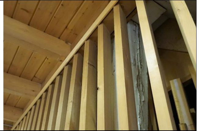
222: Bærende søylor i andre etasje.
