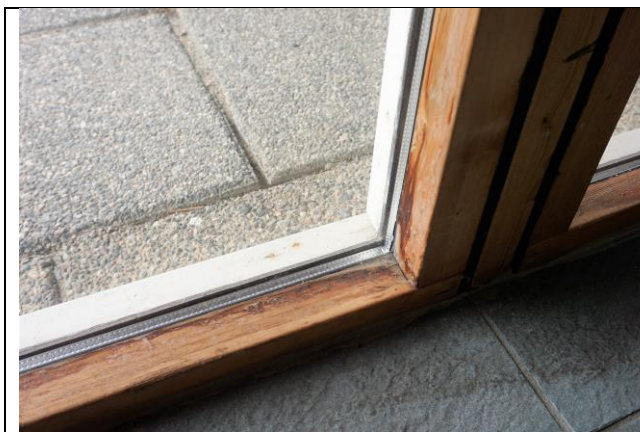
234-2: Kondensskader innside.
