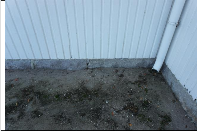
217: Drenering på nordre side.
