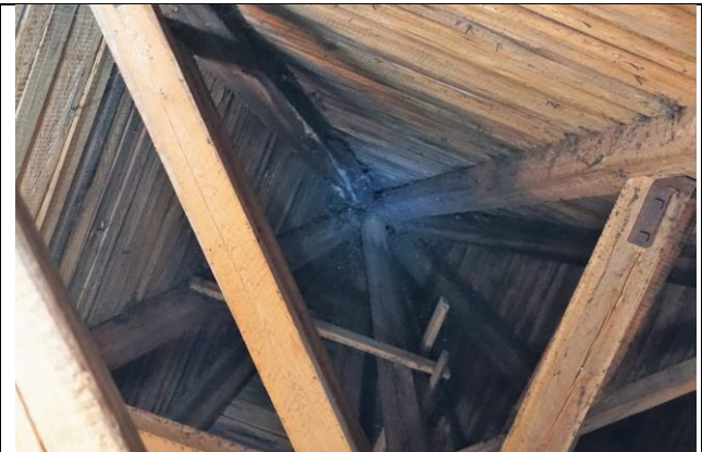
261-1 Indre konstruksjon i tre i tårn med sopp.
