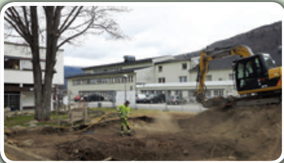
Bildet syner arbeidet med å frigjera røtane med luftspaden.
