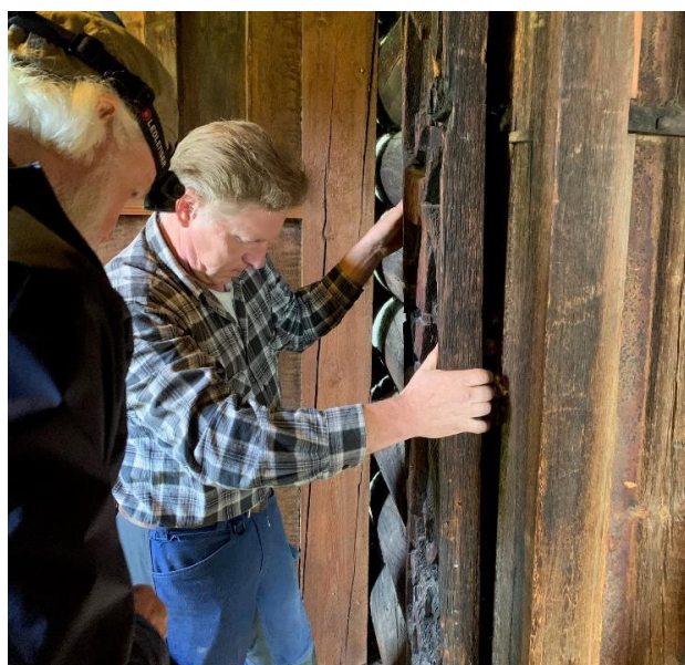
Fra demontering av portalplankene. Edvin Espelund og Svein Bakken i aksjon. (Foto: Steinar Grønn)
