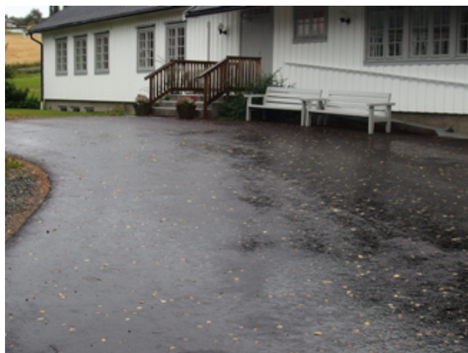
Alle veier, parkeringsplasser og området rundt menighetshuset fikk asfaltdekke i høst.
