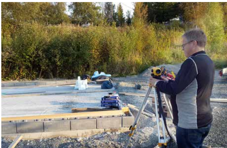
Måler: Kirkevergens FDV-ansvarlige, Ingebrigt Sandblast, har børstet støvet av nivelleringskikkerten og justerer krona på grunnmuren til det nye redskapshuset på Skatval med millimeterpresisjon.
