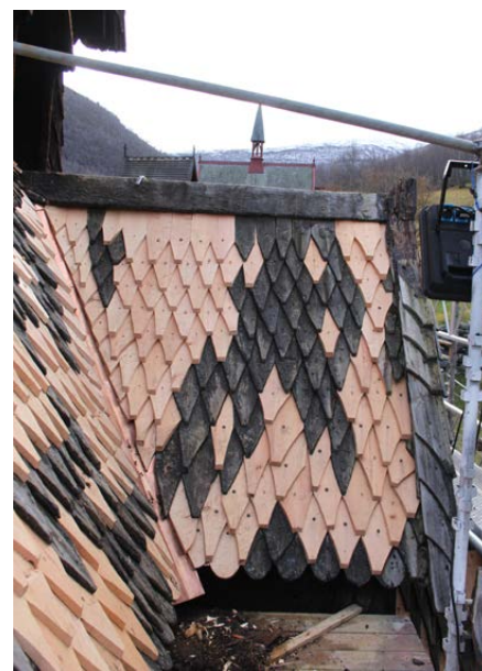
Kun dårlege takspone vart bytta på Borgund stavkyrkje.
