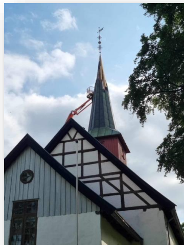
Restaurering av spir Sem kirke.
