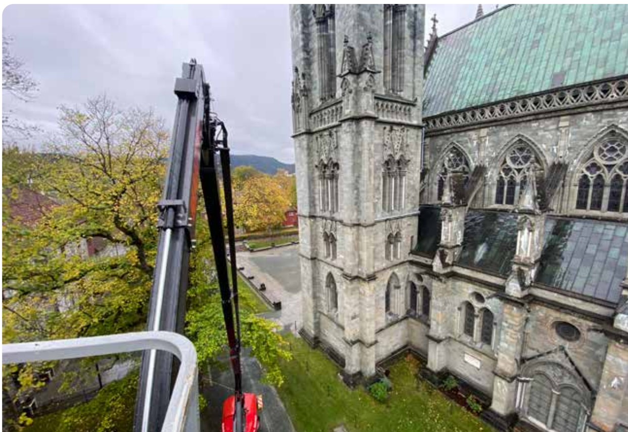
Luftig felling av trær fra lift. Foto: Yngvil Bjellaanes
