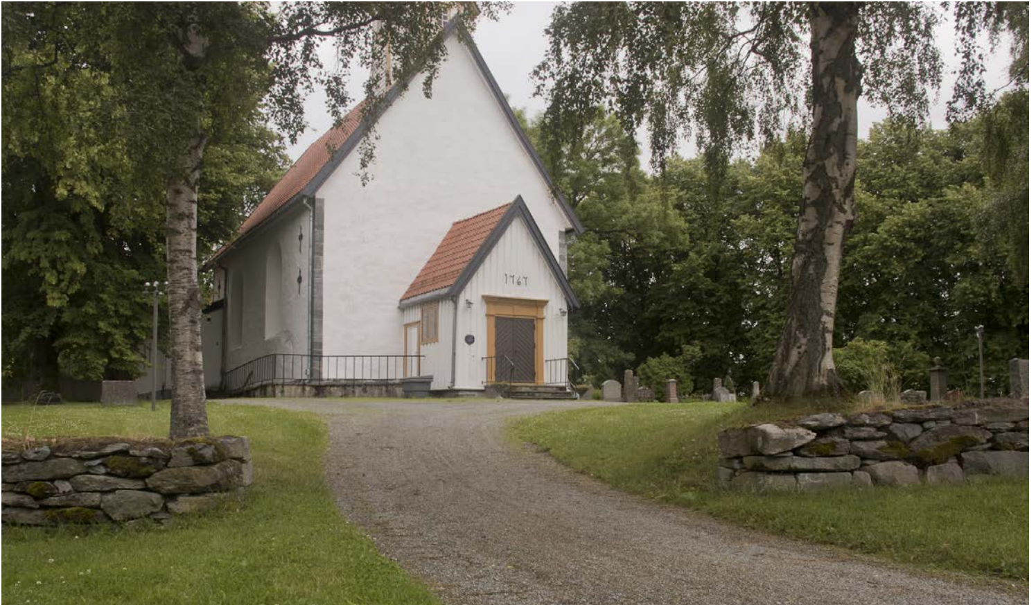
VERNEVERDIG ELEMENT: Den indre tørrmuren skiller kirken og den eldste delen av gravplassen fra det øvrige anlegget.
