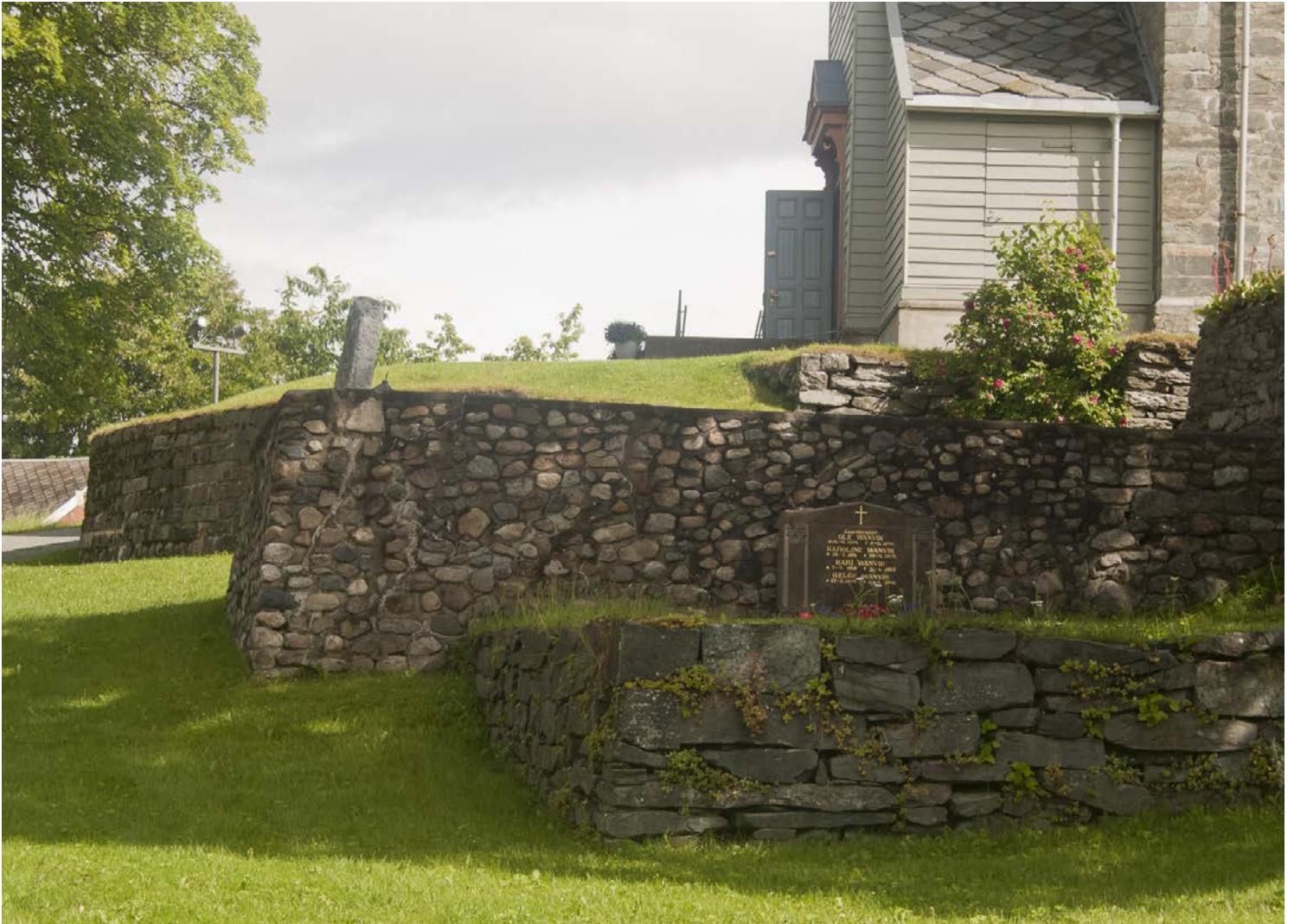
TEKNIKKHISTORISK VERDI: Terrasser i murt stein og tørrmur i skråningen opp mot Havstein kirke.
