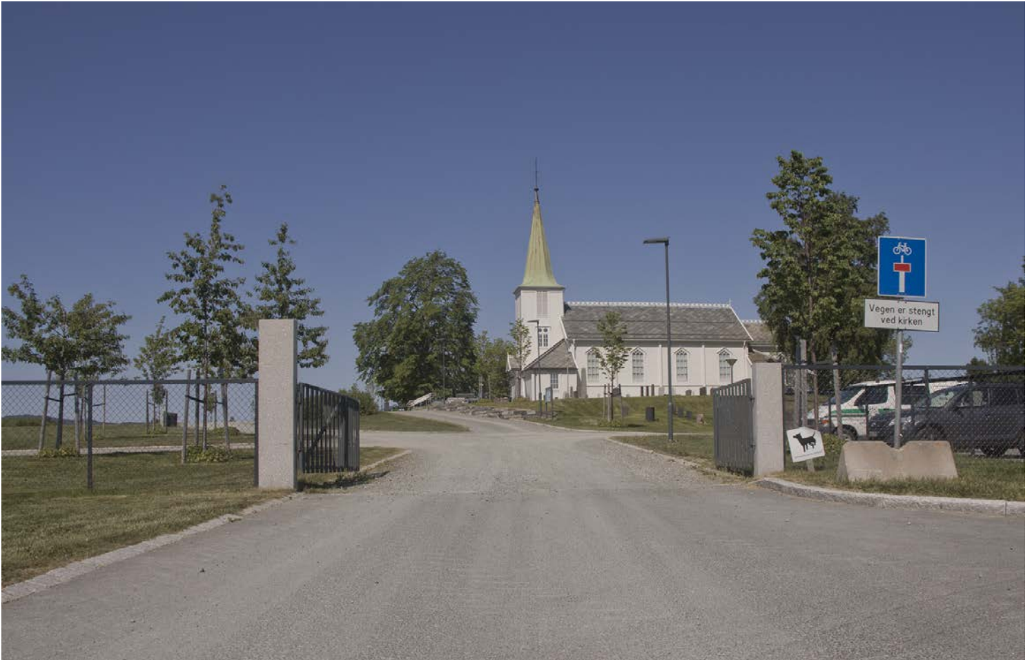
BESTANDIGE ELEMENTER: Hovedport ved parkeringsplassen.
