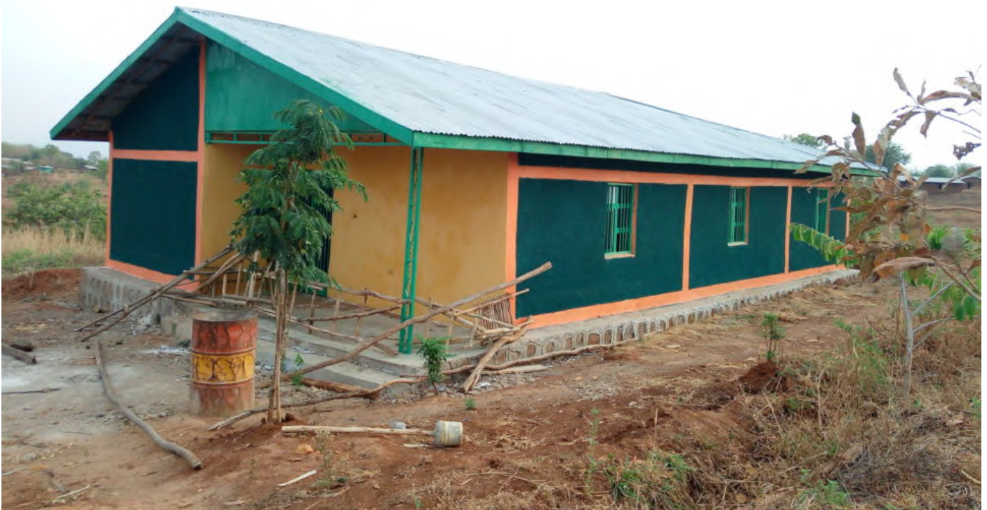
Gjestehuset på den nye synodetomta ble bygget med midler fra Frikirken og skal skaffe inntekter til driften av synoden.
