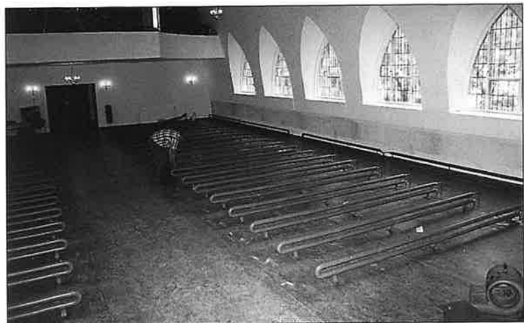
Røyrlleggjar Trond Steinsbø driv med å demontera omnar i Dale kyrkje.
