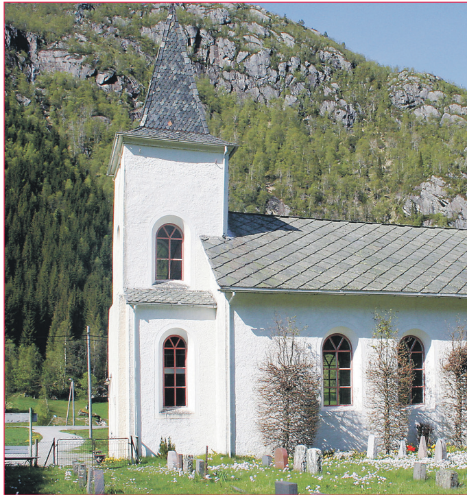
Eksingedalen kyrkje treng maling, og trea på begge langsiden vert fjerna då dei har vakse seg for store. Foto: A. M. Hoff
