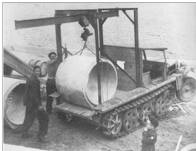
Arbeid på vegen mellom Tyin og Tyinholmen. Redskapen som ble brukt var en gammel tysk Steyr beltebil med luftavkjølt motor. Løpebommen var laget ved Vegvesenets eget verksted på Fagernes.
