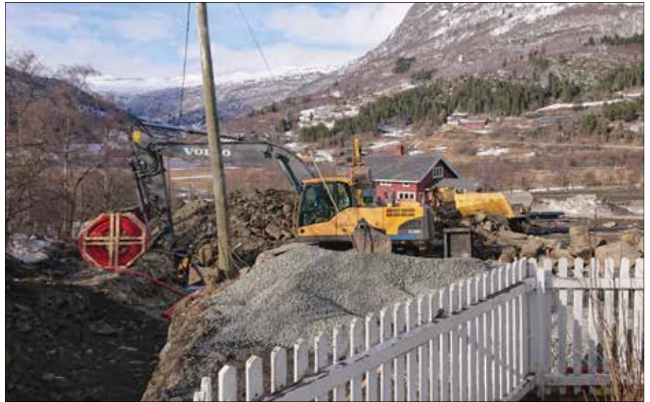
Oversiktsbilde der vi ser litt av stakitten rundt kyrkja, huset som er rive og stavkyrkja i bakgrunnen.
