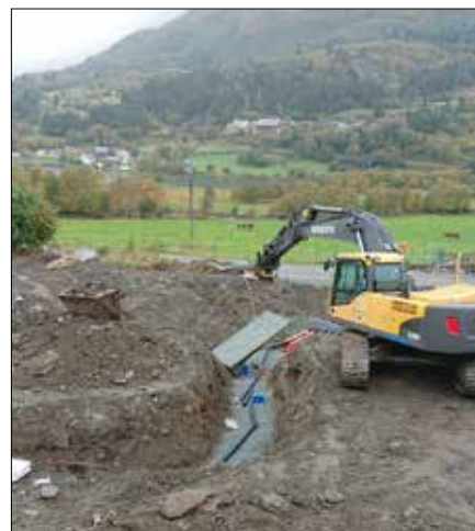
Vegkryssinga på Øyebakkin til kum og brannhydrant. Ikkje berre to røyr nei, men mange og i to høgder.
