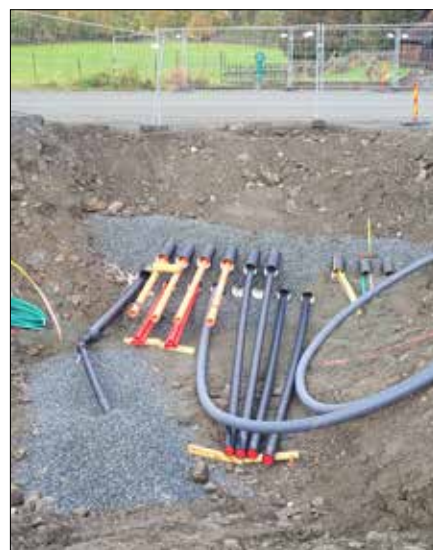
Vegkryssinga på Øyebakkin til kum og brannhydrant. Ikkje berre to røyr nei, men mange og i to høgder.
